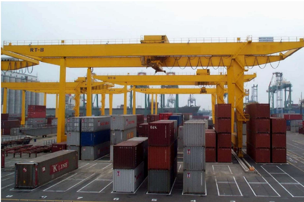
Slika 2.1: Raspored kontejnera u skladištu. Izvor: [3].
